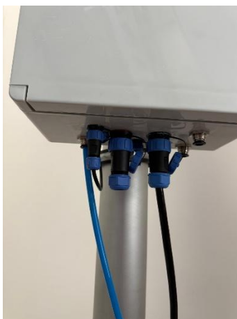
Anschluss an den Kompressor
